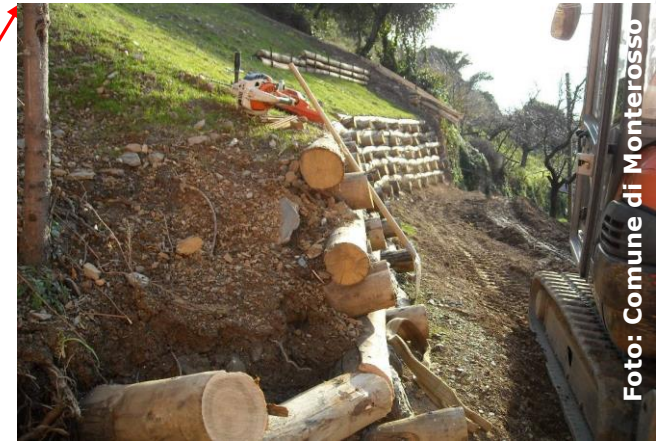
Interventi in corso (particolari costruttivi)
