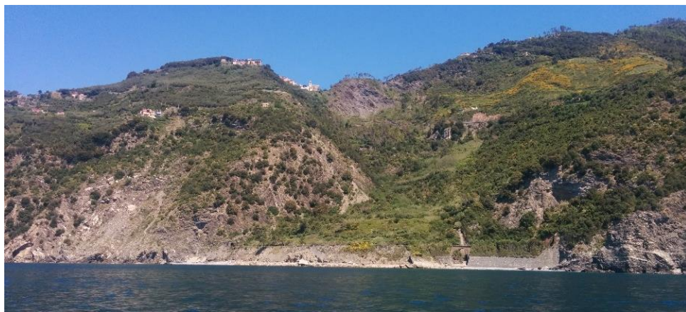
FRANA DI GUVANO
